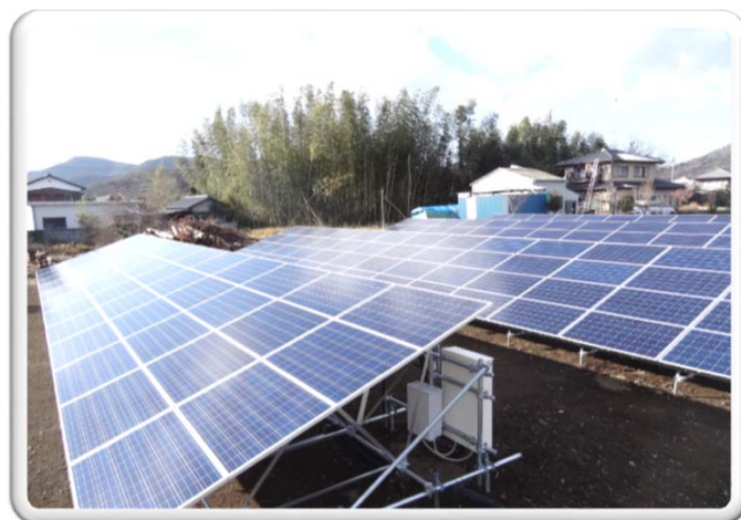
現場の写真(例2)
