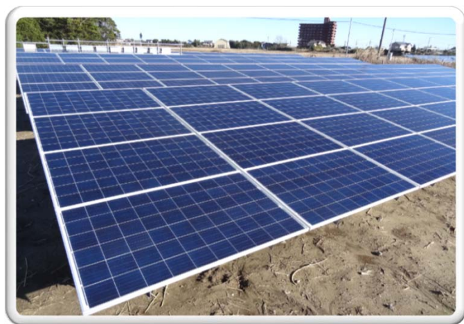
現場の写真(例1)
